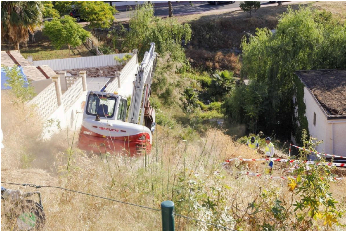
Acosol ultima los trámites para renovar 6 km de tubería a su paso por Benalmádena.
