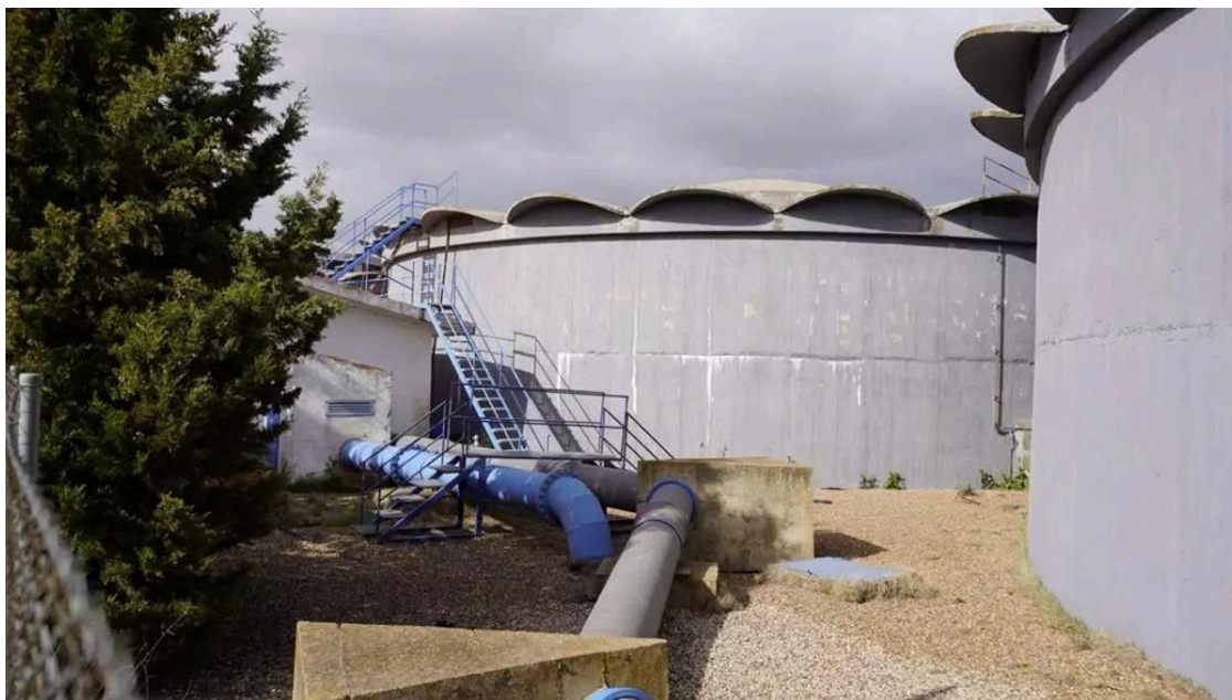
Depósitos municipales de agua de Pozoblanco. / Rafa Sánchez
