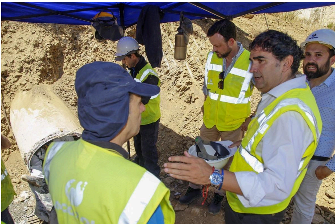
El presidente de Acosol, Manuel Cardaña, destaca la necesidad de acometer la autovía del agua para renovar la red de la Costa del Sol.
