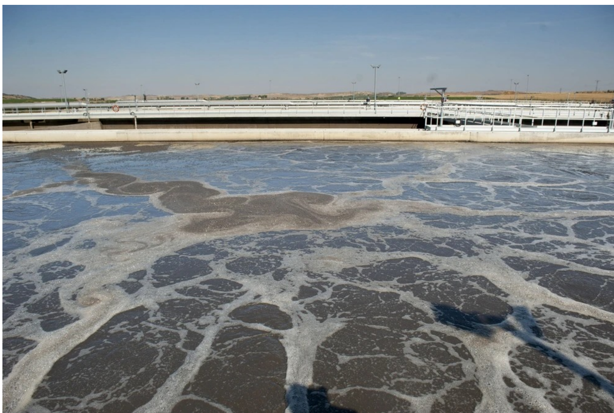
La depuradora de Estivel. - Foto: Yolanda Lancha
